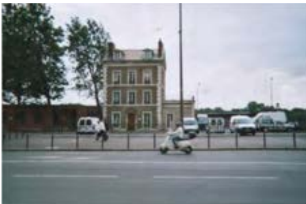
176- Maison éclusière n° 8 du canal Saint-Martin, 2010.
