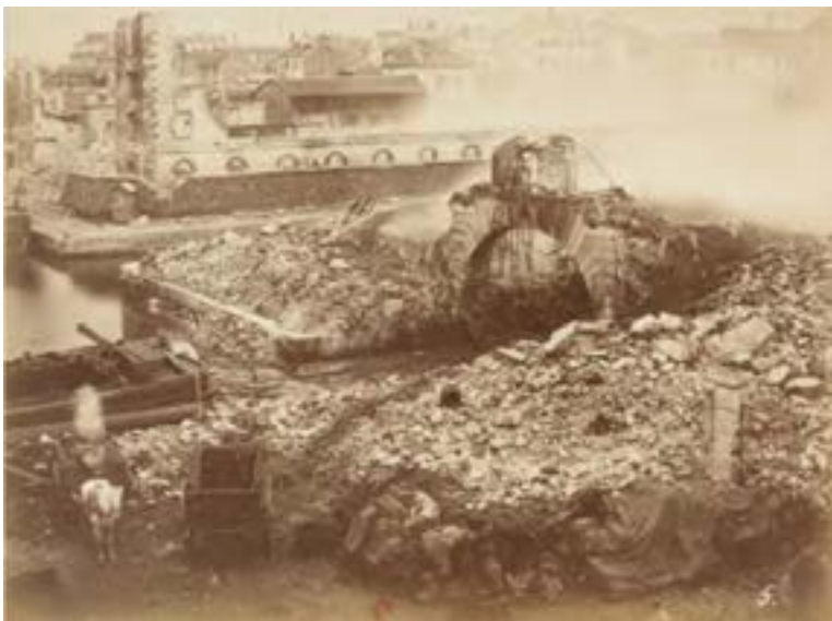
136- Entrepôts du pont de la rue de Crimée après l'incendie de 1871.
