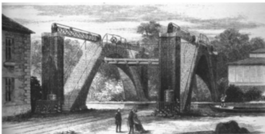
209- Pont mobile sur le canal de l'Ourcq reliant le marché aux bestiaux aux abattoirs généraux, 1869.
