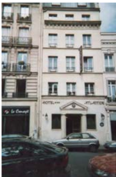
165- Maison pontonnière n° 5 du canal Saint-Martin, 2010. Cliché S. Guével. Après la couverture du canal Saint-Martin et la destruction des ponts mobiles, cette maison pontonnière a été louée pour des durées de trois à neuf années. En juin 1869, un certain Servant, pharmacien, a loué dans cette maison, quatre caves, deux boutiques ayant leurs entrées sur la rue de la Folie Méricourt, une arrière-boutique ayant une entrée sur le boulevard Richard-Lenoir, une pièce à usage de salle à manger, un logement à l'entresol comprenant trois pièces éclairées sur le boulevard et deux pièces sur la rue de la Folie Méricourt (A.S.C.V.P.). Aujourd'hui, elle abrite un hôtel.
