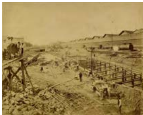
127-2- Chantier de la 1 ère écluse du canal Saint-Denis, 1891. Vue vers Saint-Denis.
