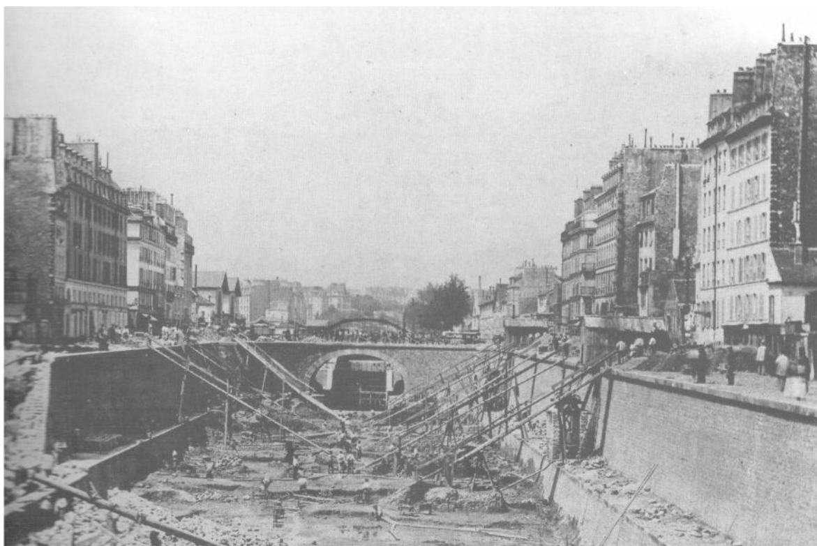
14- Chantier de déblai de la cuvette du bassin du Temple pour l'établissement de la couverture du canal Saint-Martin, vers 1860. FRANCK, Canal Saint-Martin, Chantier de déblai de la cuvette du bassin du Faubourg du Temple, vers 1860, B.H.V.P. G.P. XLIII 14. Publié dans l'ouvrage de TEXIER Simon (dir.), Les canaux de Paris, Paris, Délégation à l'Action Artistique de la Ville de Paris, Coll. « Paris et son patrimoine », 1994, p. 151. Cliché J.-C. Doerr.
