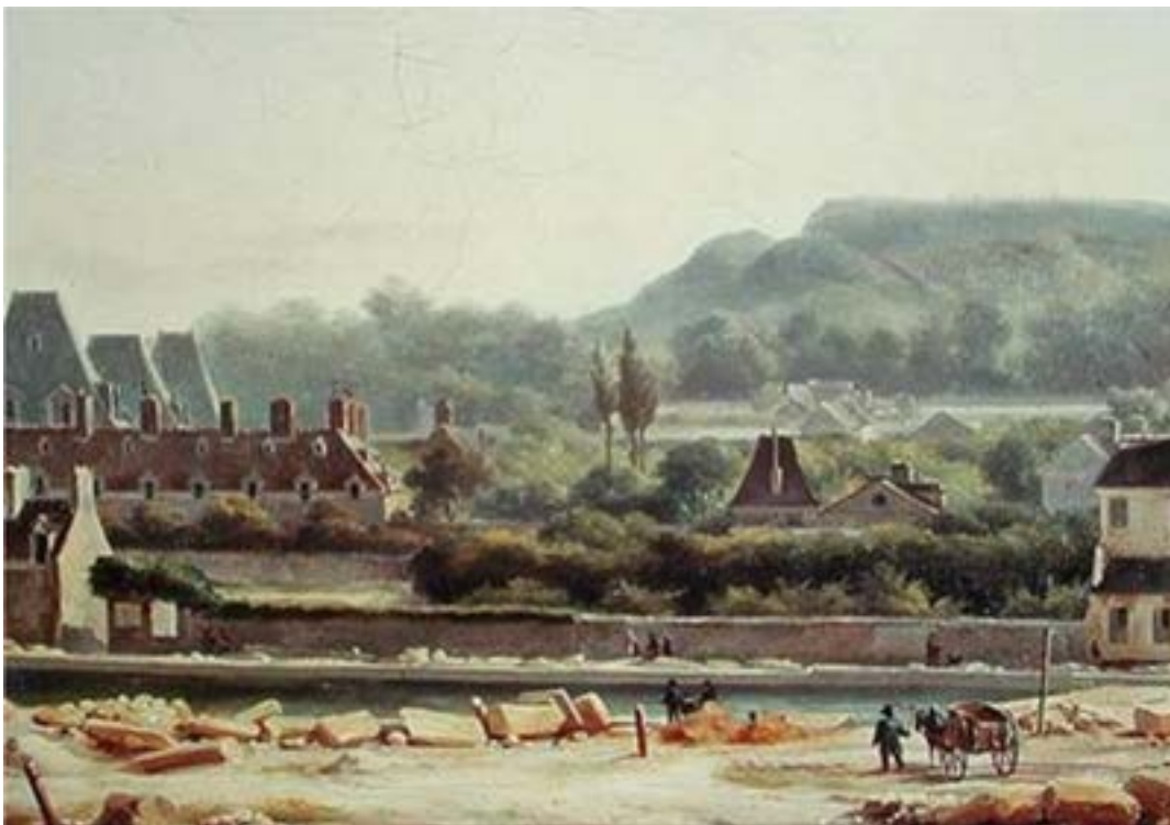
72- Vue du chantier du canal Saint-Martin, vers 1825.
