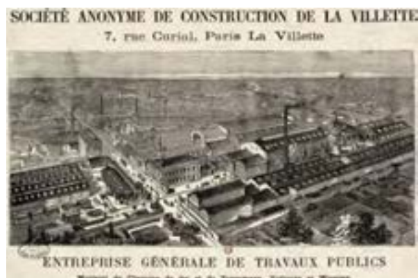
213- Société anonyme de construction de La Villette, Entreprise générale de Travaux Publics, 7, rue Curial, vers 1880.
