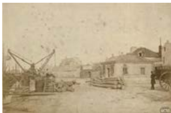
110-4- Chantier de bois. A.P. 11Fi 1307.
