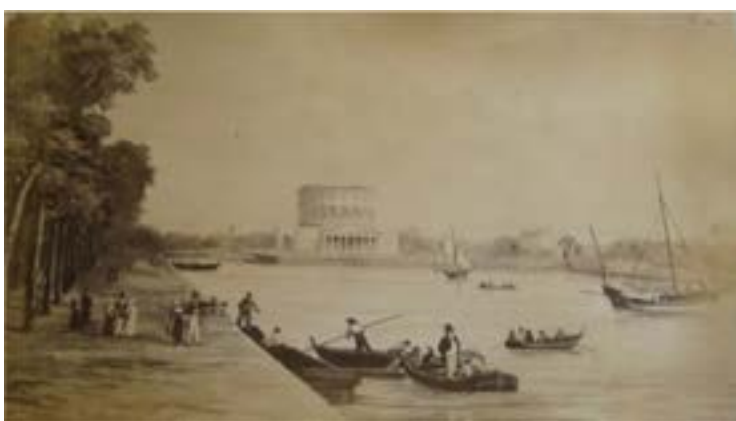
136- Vue du bassin de La Villette depuis le quai de la Loire, vers 1820. MADELEINE Y., « Bassin de La Villette », in BELGRAND E., Inspecteur général des Ponts et Chaussées Directeur, BUFFET A.-L., Ingénieur en chef des Ponts et Chaussées, DURAND-CLAYE A., Ingénieur des Ponts et Chaussées, Bassin de La Villette, Ville de Paris, Direction des Eaux et Égouts, Canaux, Paris, 1877, Planche 16, A.N. Atlas 1026 ou A.S.C.V.P. Publié dans l'ouvrage de Jean-Marie (dir.), Le XIX ème arrondissement, une cité nouvelle, Paris, Délégation à l'Action Artistique de la Ville de Paris, Coll. « Paris et son patrimoine », 1996, p. 45. Cliché A.S.C.V.P.
