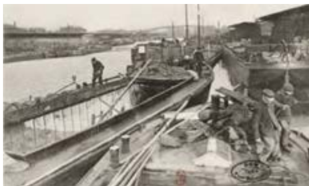
173- Déchargement de bateaux au bassin de La Villette, 1909.
