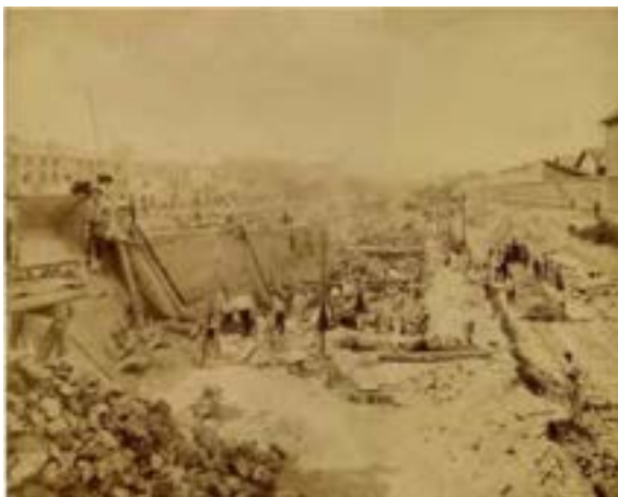
127-1- Chantier de la 1 ère écluse du canal Saint-Denis, 1891. Vue vers Saint-Denis.
