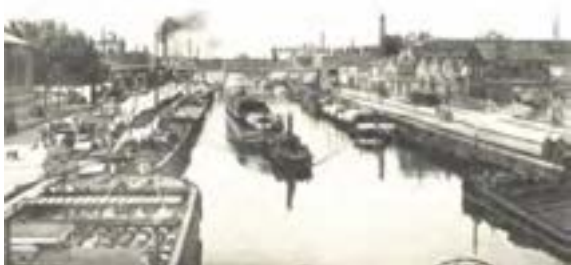
152- Bassin élargi depuis le pont de le rue de Crimée, 1902.
