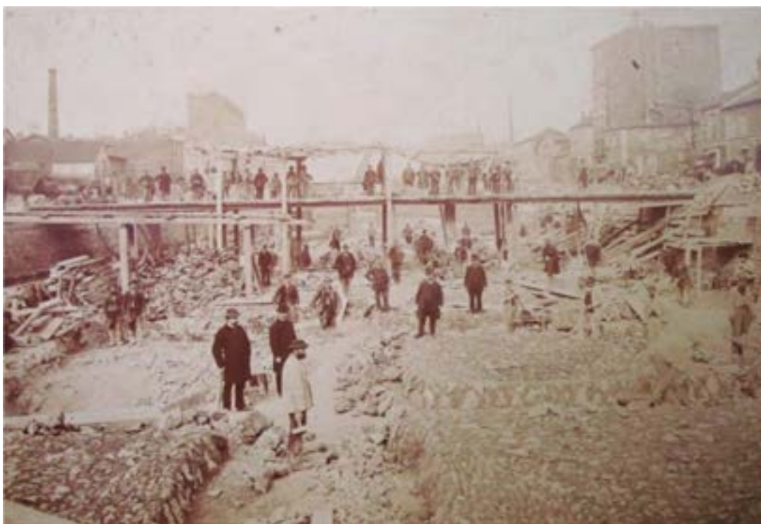
16- Travaux d'abaissement du canal Saint-Martin, vers 1860.
