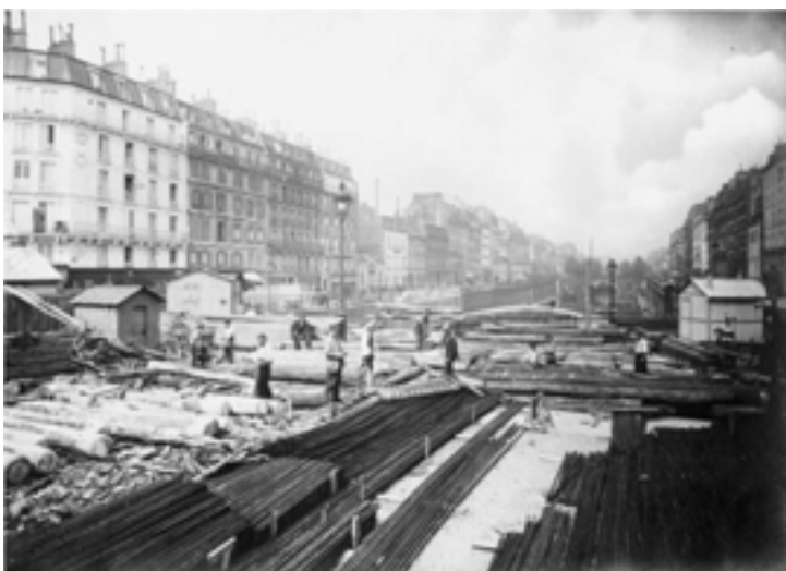
38- Emplacement réservé au chantier de la couverture du bassin du Temple, comprenant la rue Rampon et une partie du terre-plein longeant l'avenue de la République, 1907.
