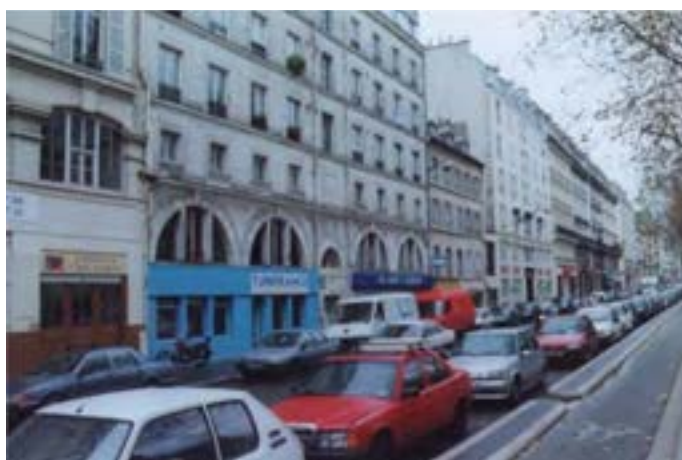
69- Immeubles construits dans les années 1830-1840, rive gauche, sur les emprises de la Nouvelle Ville d'Angoulême coupée par le canal Saint-Martin, 2010.
