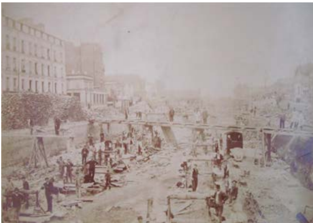
15- Travaux d'abaissement du canal Saint-Martin, vers 1860.
