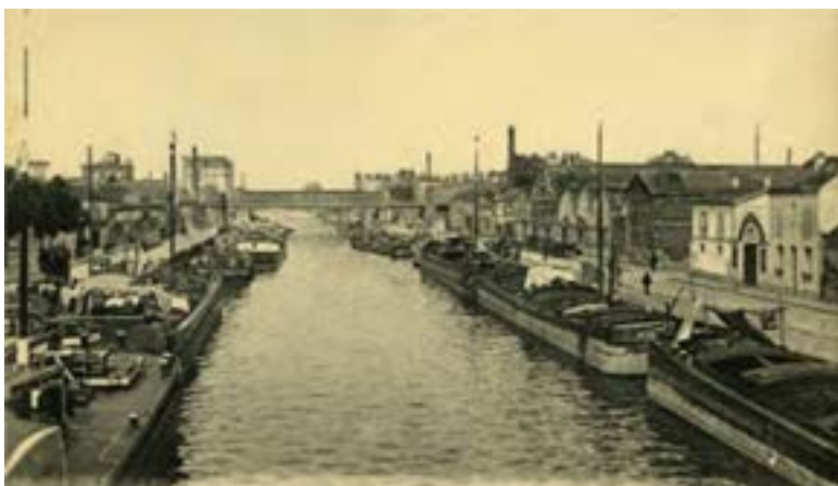
186- Nouveau pont métallique à une seule portée de la rue de l'Ourcq, vers 1920-1930. Anonyme, Le canal de l'Ourcq, quai de la Marne, Paris, Éditeur F. Fleury, n° 158, vers 1920-1930, Collection particulière ( http://www.cparama.com/forum/paris-quai-de-la-marne-t15351.html ). Cliché CPArma.
