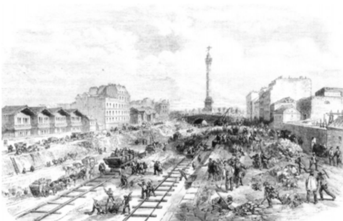
13- Travaux d'abaissement du canal Saint-Martin en amont de la place de la Bastille, 1860. Anonyme, « Chantier d'abaissement de la cuvette du canal Saint-Martin », L'illustration, 18 février 1860, A.S.C.V.P. Cliché A.S.C.V.P.
