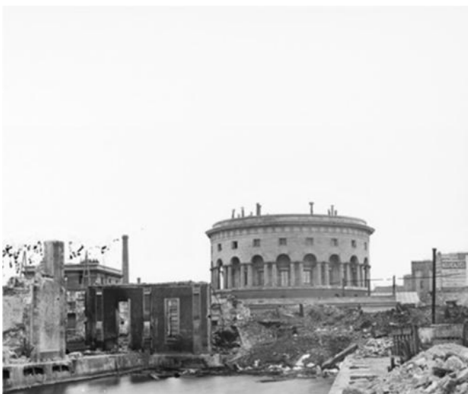
131- Entrepôts de la place de l'Ourcq après l'incendie de 1871. BLANCARD H., Commune de Paris (1871). Bassin de La Villette. Docks de La Villette incendiés postérieur au 18 mai 1871, 1871, B.H.V.P., P.P., Collection H. Roger-Viollet 60439-8. Cliché P.P.
