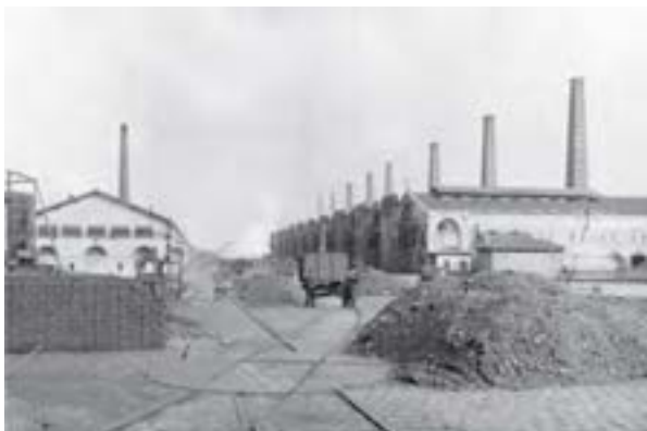
212- Usine à gaz de La Villette, rue d'Aubervilliers, 1905.
