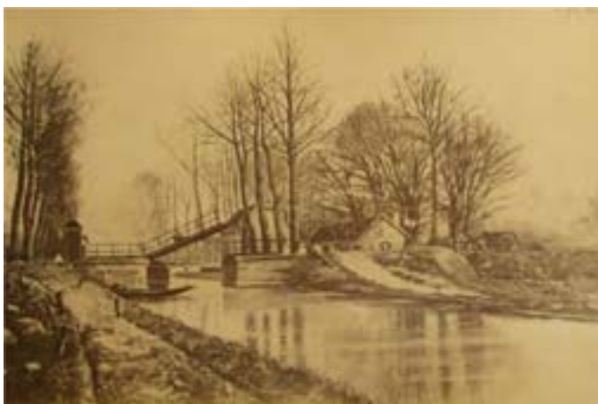
114- Pont mobile type sur le canal de l'Ourcq, vers 1820.
