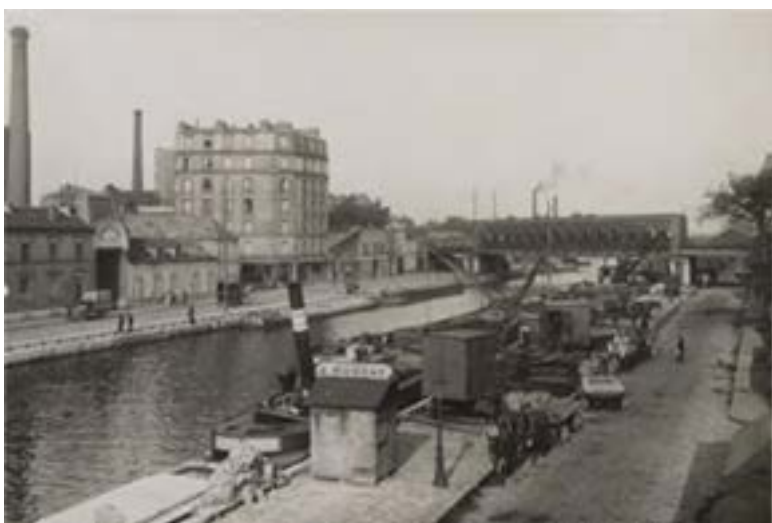
188- Nouveau pont du chemin de fer de Ceinture, 1916. LANSIAUX C., Quai de l'Oise et canal de l'Ourcq, 30 septembre 1916, B.H.V.P., P.P., Collection H. Roger-Viollet 49814-20. Cliché P.P.
