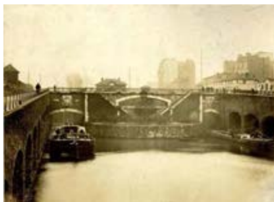
127-4- 1 ère écluse du canal Saint-Denis, 1892. Vue vers Paris de la double écluse et du 1 er bief.
