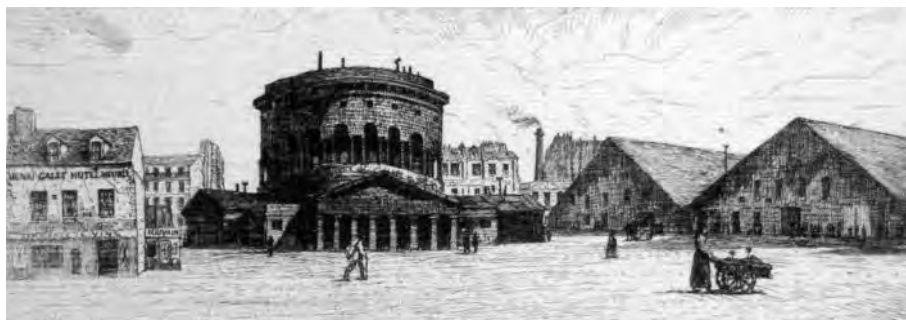
29- Entrepôts de stockage sur la place de l'Ourcq, vers 1855.
