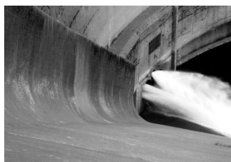
Barrage de Palisse ©BETCGB
