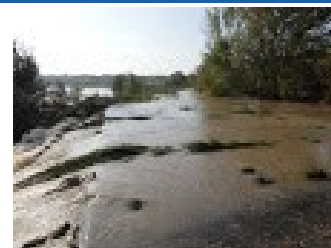
Digue de la Mosson ©Mairie de Lattes
