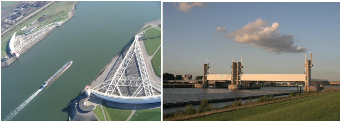
Figure 52 : Vannes secteurs (Measlant-kering) et vannes levantes (Hartelkering) aux Pays-Bas – sources : images libres de droit Seabrook floodgates, Nouvelle Orléans - source : USACE
