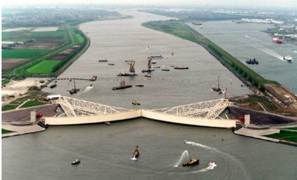
Figure 30 - Maeslant Barrier, Pays-Bas
