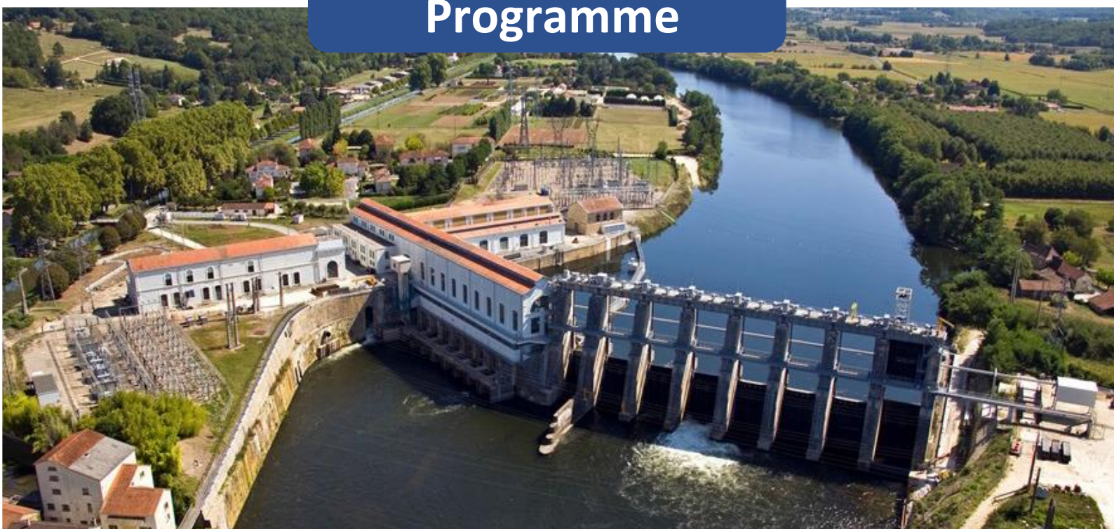
EDF - Barrage de Tuilières sur la Dordogne
