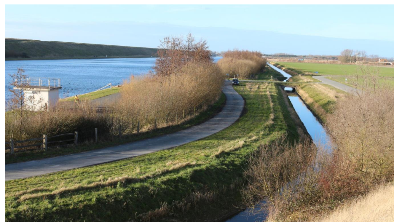
Un vaste réseau hydraulique, appelé système des waterings, permet de drainer les eaux du polder (Source AGUR)
