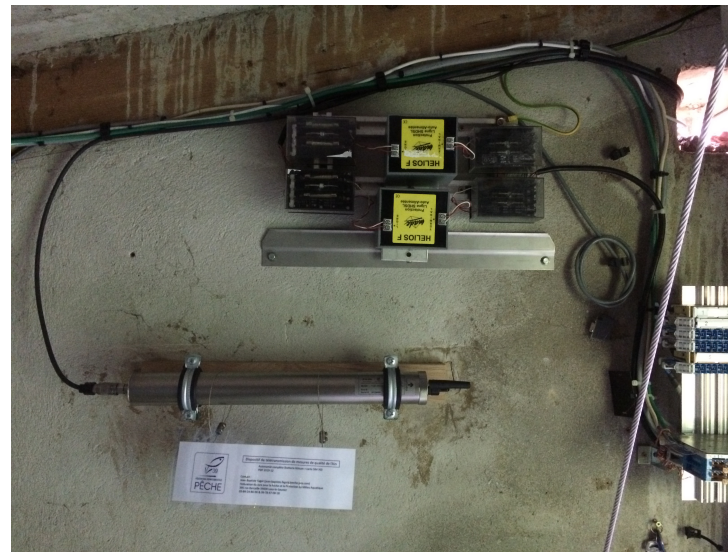
Modem installé dans un abri hydrométrique
