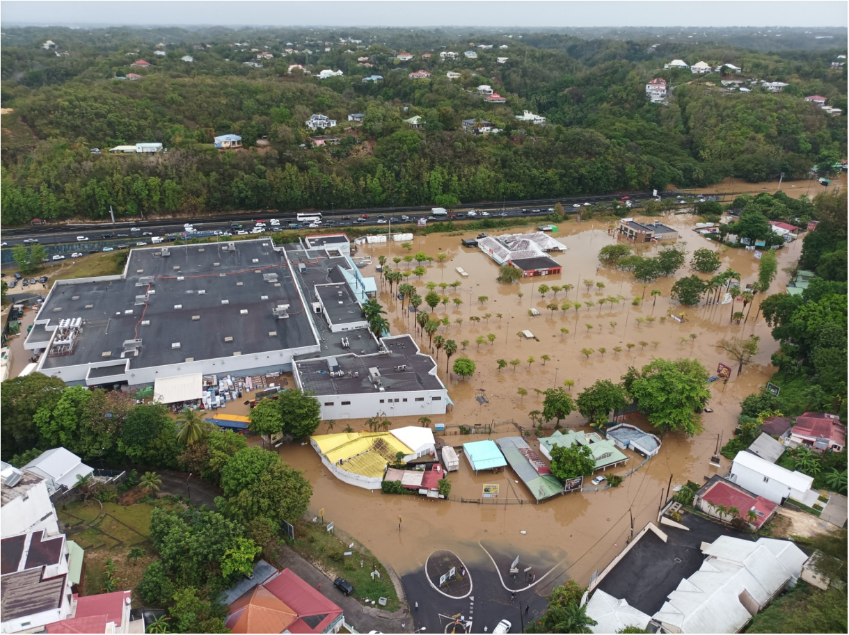
Figure 2: Inondation du centre commercial des Abymes lors de l'épisode pluvieux du 30/04/22
