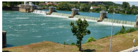
Figure 1 : exemple de barrage mobile sur la Saône – le barrage de Couzon (Source VNF)
