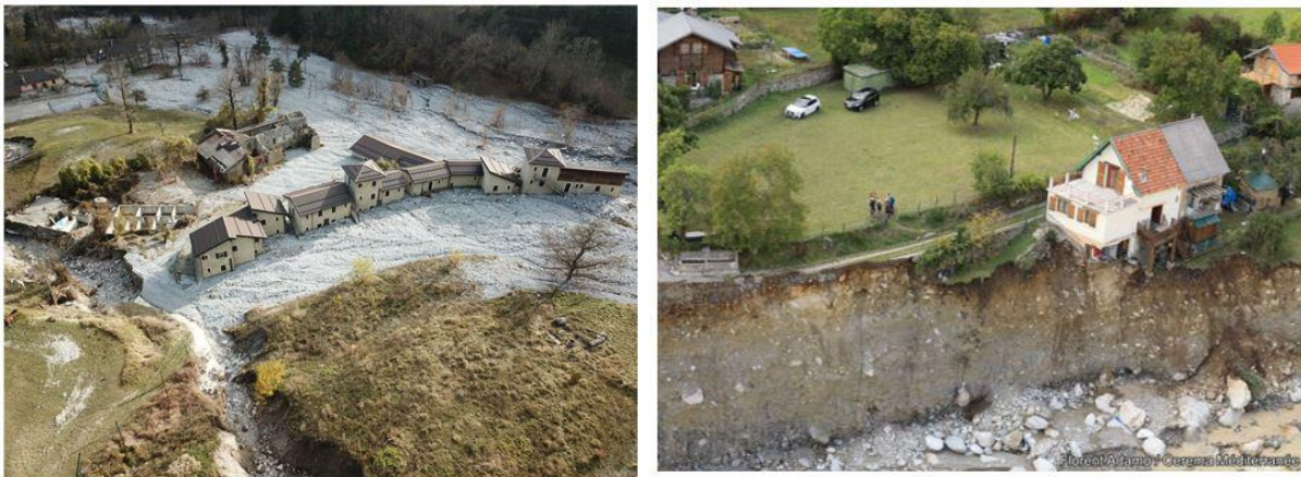
Figure 1 : Photos de terrain post évènement : (gauche) Vue drone, Vieville (source V. Koulinski ETRM) ; (droite) érosion de berge menaçant un bâti (source : F. Adamo Cerema)
