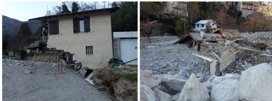
Figure 6 : Photos de terrain post événement : (gauche) St Dalmas de Tende, endommagement par affouillement des fondations (Source : ONF-RTM) ; (droite) St Martin Vésubie, endommagement par engrèvement (Source : ONF-RTM)
