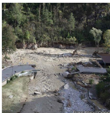
Figure 7 : (gauche) Tende, pont des 14 arches détruit (Source : F. Adamo, CEREMA) ; (droite) Nombre et fréquence des niveaux d'endommagement en fonction du type de pont
