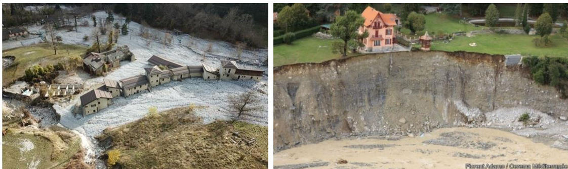
Figure 1 : Photos de terrain post événement : (gauche) Dépôt sur le cône de déjection du torrent de la Morte avec bâtis engravés près de Viévol en Haute-Roya (Source : V. Koulinski, ETRM) ; (droite) Erosion de berge menaçant un bâti à St-Martin-Vésubie (Source : F. Adamo, CEREMA)
