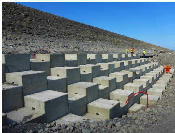
Figure 4 : Blocs attachés de forte rugosité pour protéger la berge et favoriser le méandrement des bras vifs - Rivière des Galets Réunion
